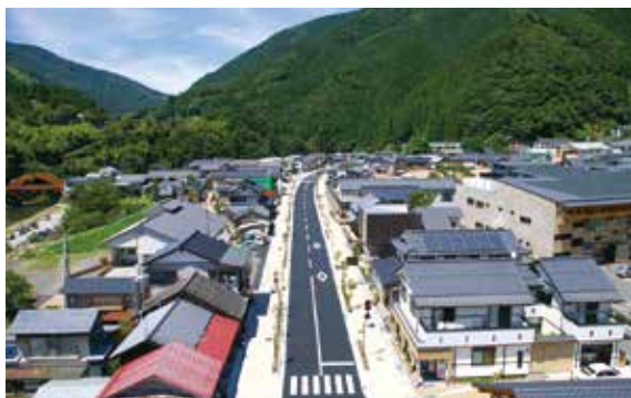
町中心地 梶原町の中心地の写真です。隈研吾氏が設計した梶原町役場総合庁舎が写真右中ほどに見えます
