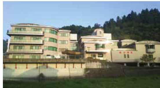
梶原病院・保健福祉支援センター 玄関を共有し、向かって左側が保健福祉支援センター、右側が国保梶原病院です
